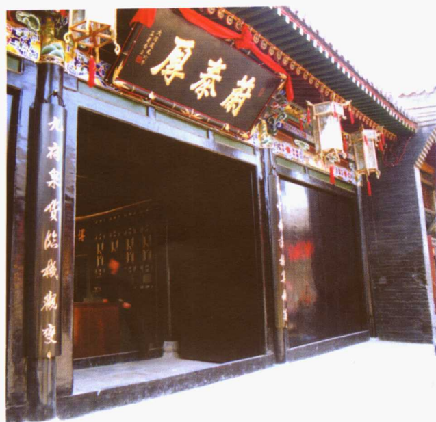
蔚泰厚票号旧址(摄于2002年10月)
