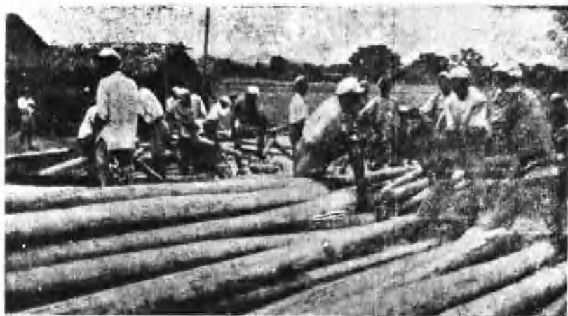
四兵团某部指战员在开平境内紧张抢修桥梁。
