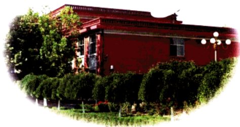
1972年建成的文科教学楼
