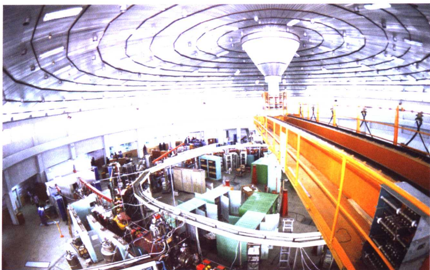
国家同步辐射实验室二期工程为国家“九五”大科学工程项目；图为实验室储存环大厅
