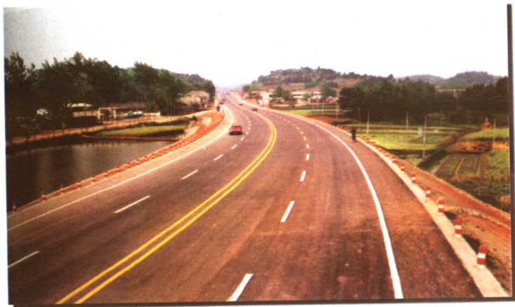
经改造后的我区第一条高等级公路 ——国道 318 线遂宁至安居段。
