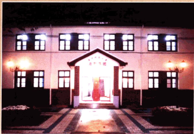
灯火通明的集团办公楼。
