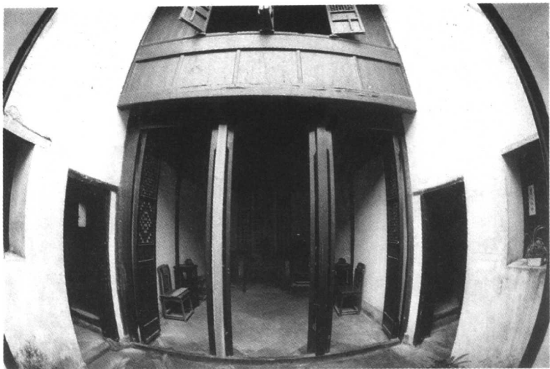
1-5·吴昌硕故居的第二进是全家的住处，为三间两层的楼房。
