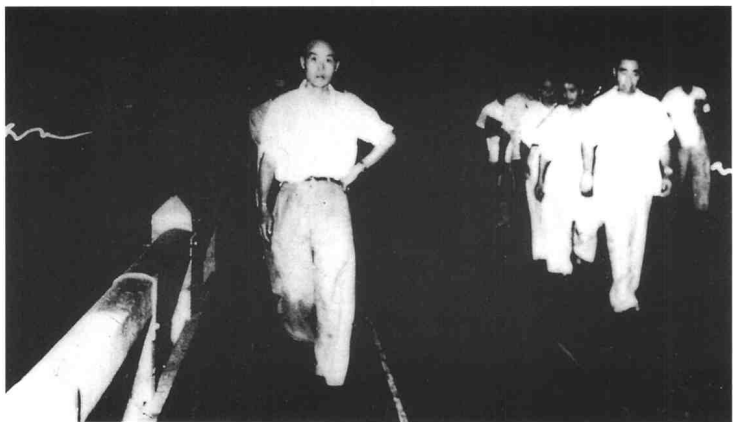
1958年8月6日傍晚，周恩来总理在山东省委第一书记舒同、济南铁路管理局第一书记李震陪同下，视察了特大洪峰中的津浦铁路泇口黄河特大桥
