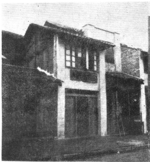
中共桂柳区工 委旧址——永兴昌 染房（原桂林市东 江自由路158号）
