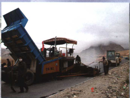
总投资11.7亿元的青藏公路整治工程2002年5月23日开工，将于2003年底竣工。
