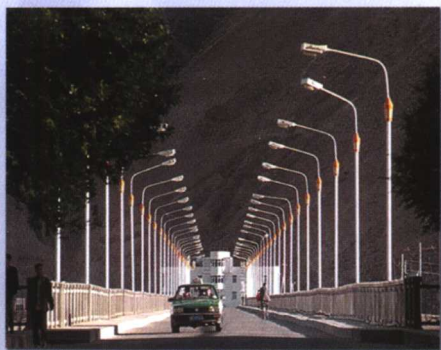
中央和地方大力支援西藏的公路建设，并修建了很多桥梁，图为连接市区和川藏公路的拉萨大桥。
