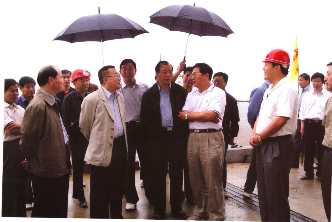
2004年5月，省长王金山在王家坝闸除险加固工程建设工地检查工作。省水利厅厅长吴存荣等陪同检查。曹健摄影
