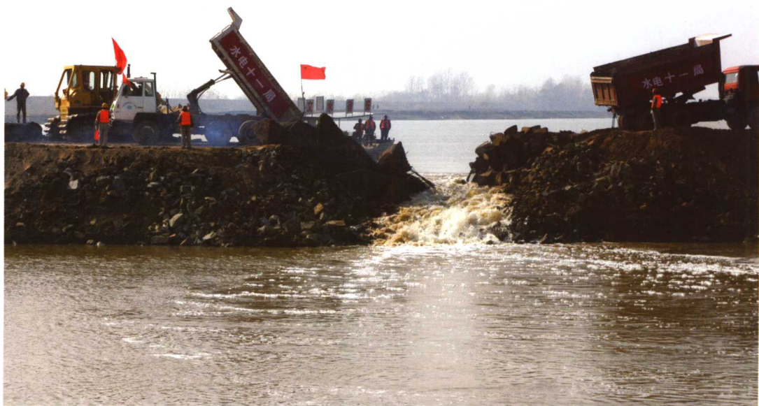
2003年11月23日，临淮岗洪水控制工程顺利实现淮河截流。
