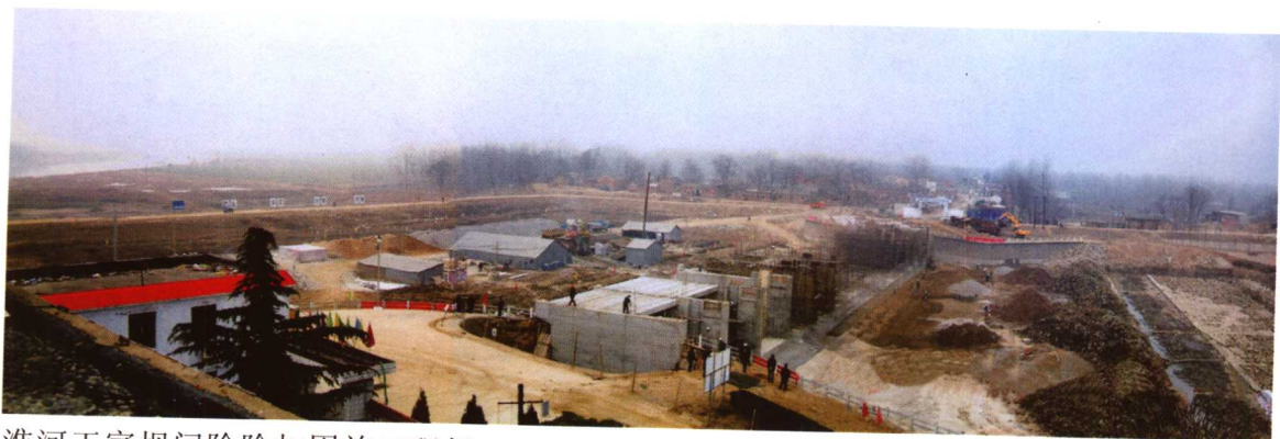
淮河王家坝闸除险加固施工现场。
