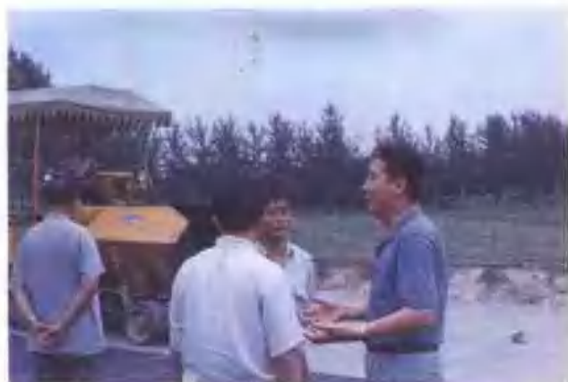
→王裕荣(右一)、范 正金(右二)在筑路 现场。
