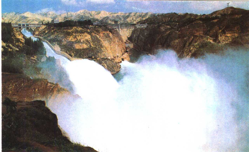
刘家峡水电站
