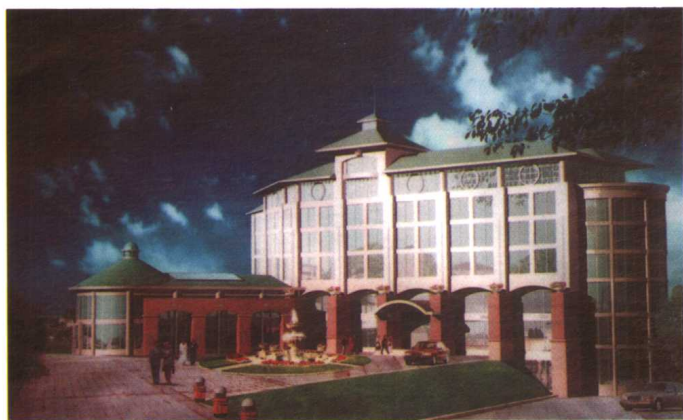
建设中的青岛分社
