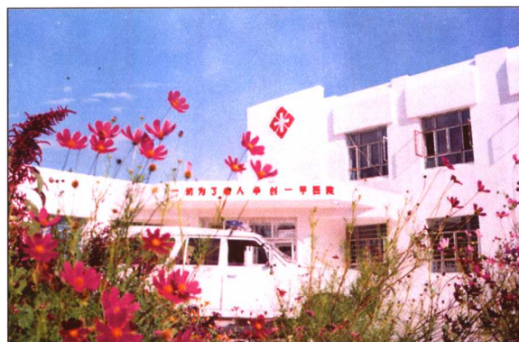
新 盖 的 医 院 病 房 楼
