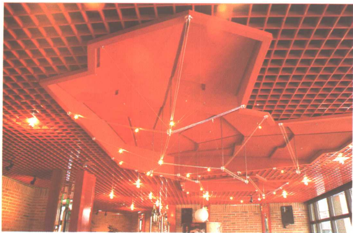
图 3-94 德国慕尼黑某咖啡室顶棚
