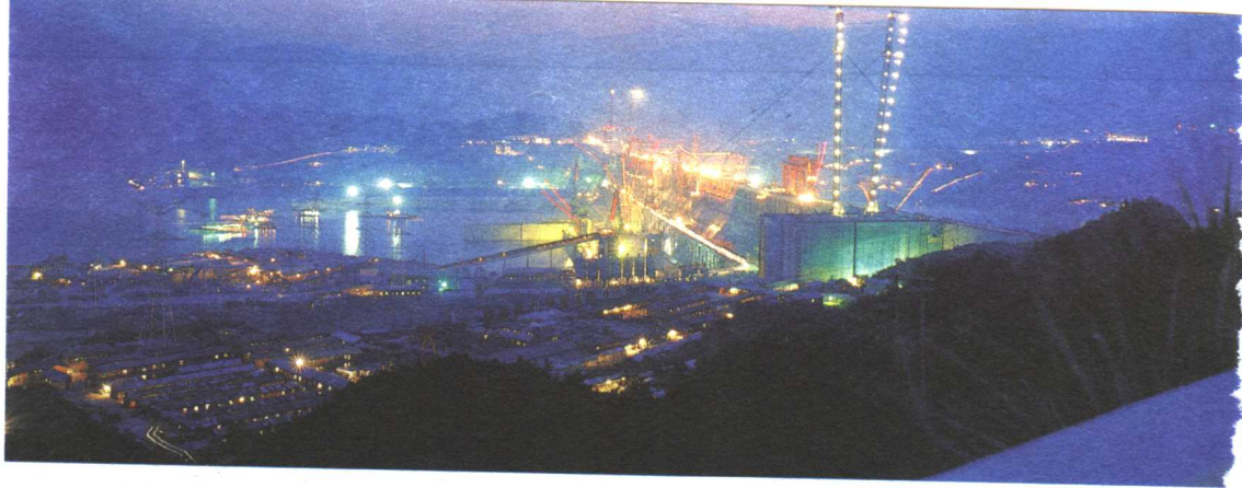
●灯火通明的三峡建设工地
