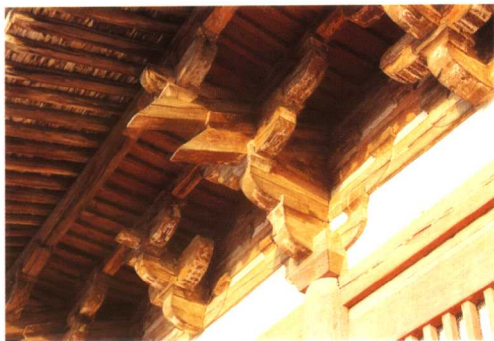
柱头斗拱的第一跳和第三跳均为偷心造，而偷心造又是唐代建筑的典型做法。
