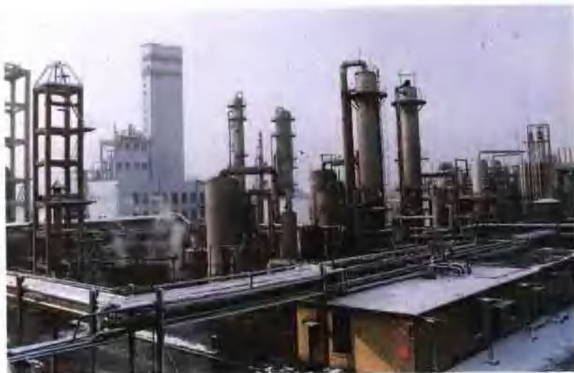
滕州市化肥厂新建的6万吨尿素生产车间外景
