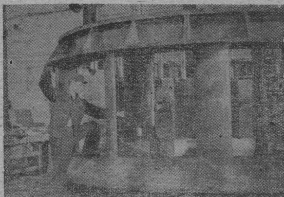
(1)正在座环上安装导水瓣
