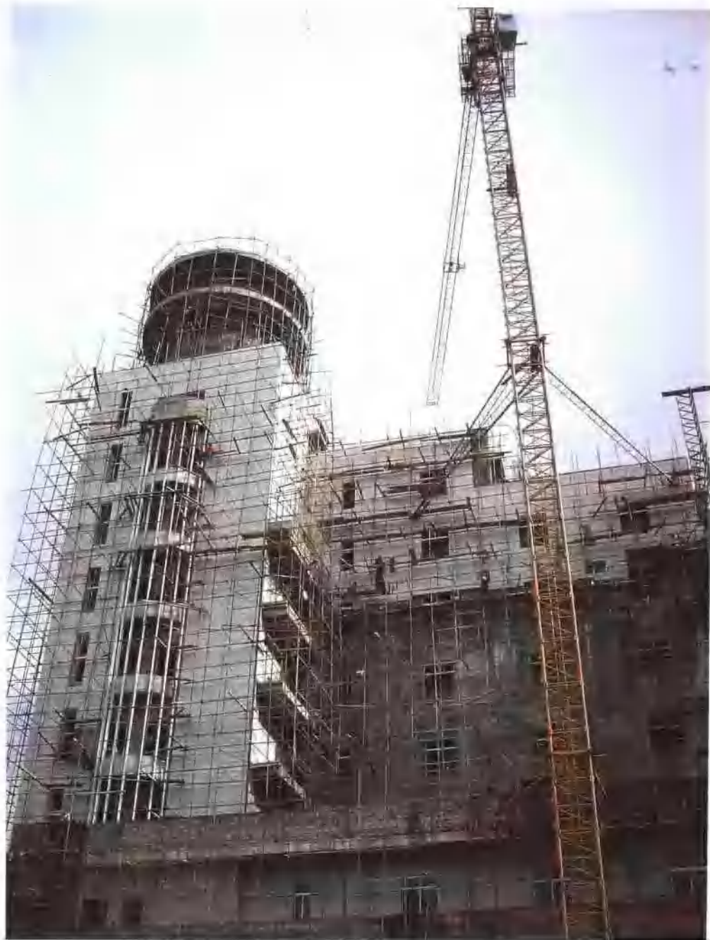
建设中的拉萨长途电话枢纽 工程大楼
