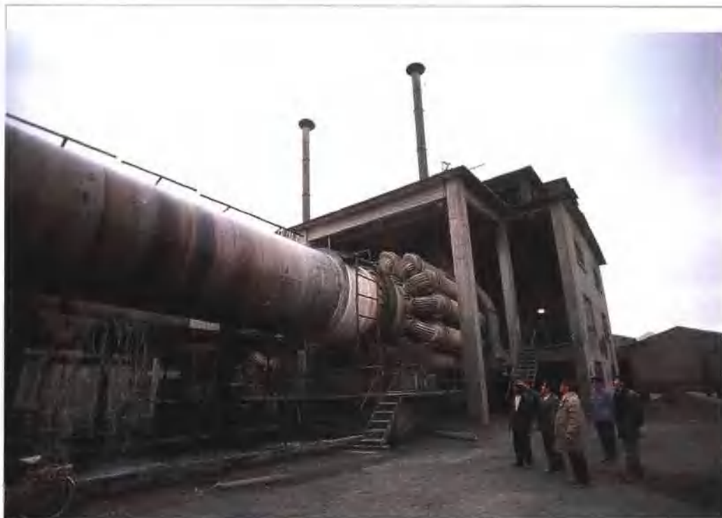
拉萨水泥厂回转窑改造已完成，开始投入生产
