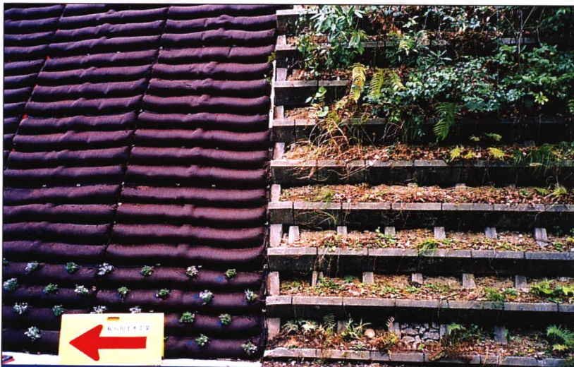
日本型式各异的山体边坡水土保持技术
