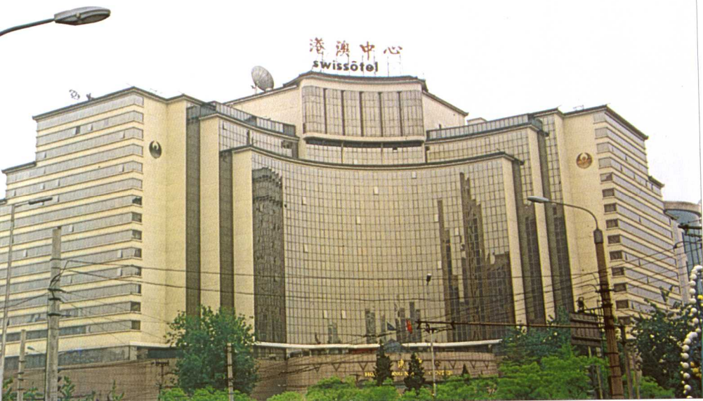
有框玻璃幕墙
