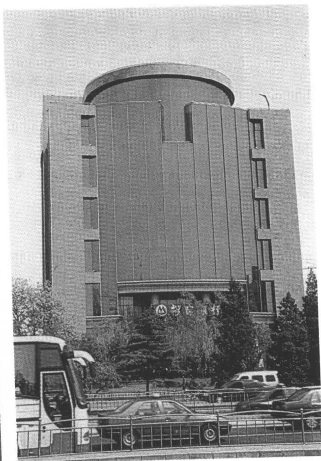
图 1-11 横隐竖框玻璃幕墙
