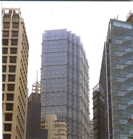
幕墙内楼梯清晰可见
