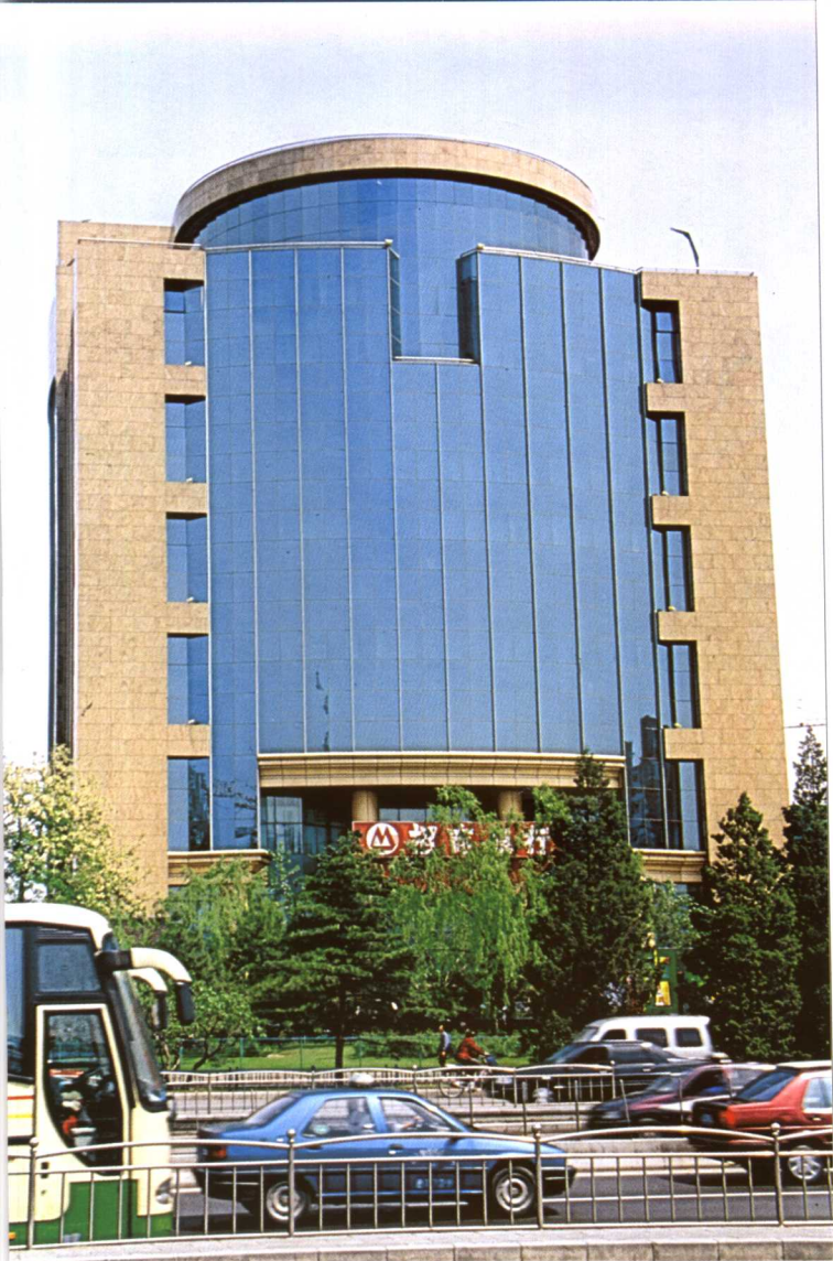
横隐竖框玻璃幕墙
