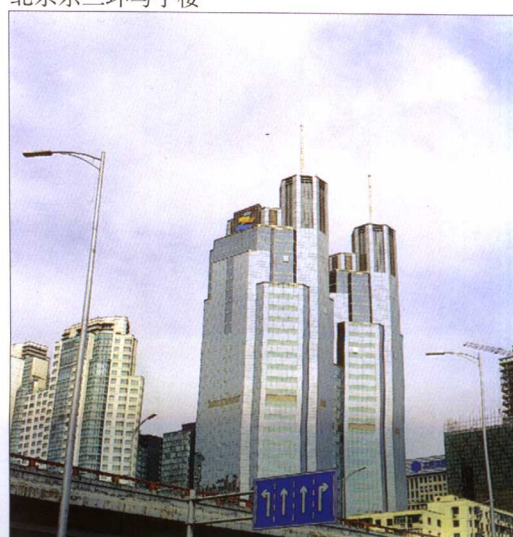
北京东三环写字楼
