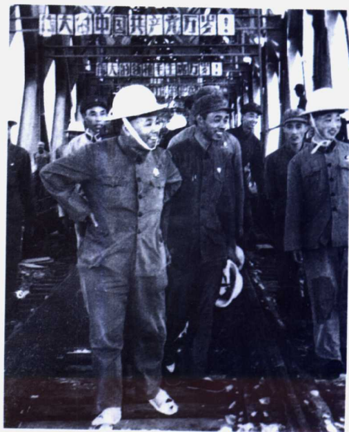
1968年，许世友检查正在施工中的南京长江大桥工地
