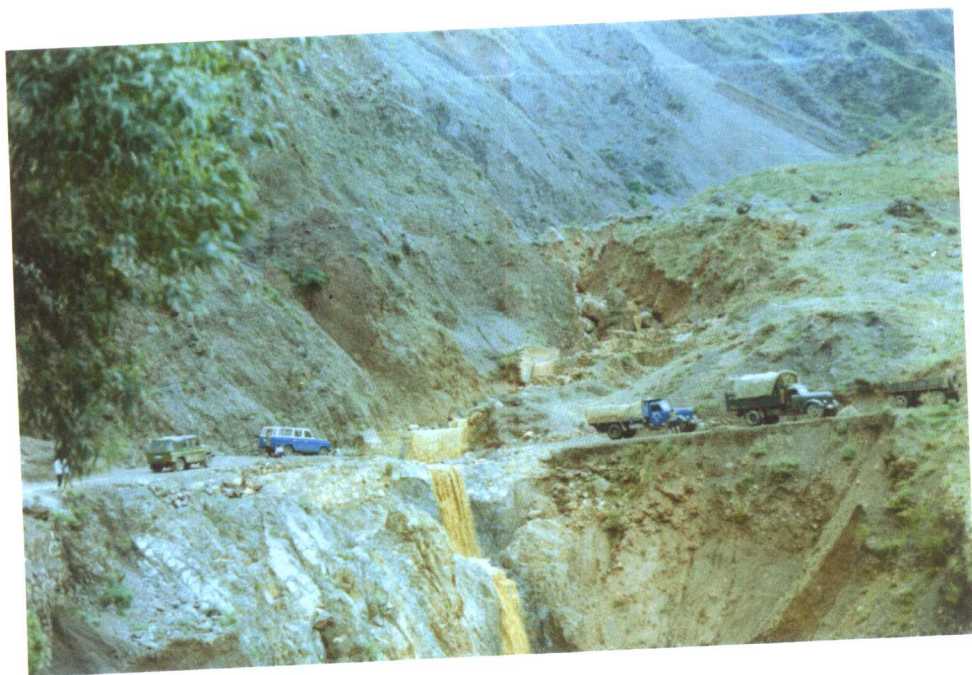
照片 2.8 泥石流冲毁公路
