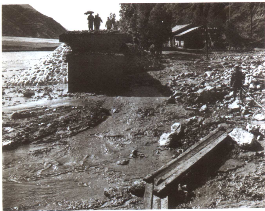
照片 2.6 泥石流冲击铁路桥并推至下游
