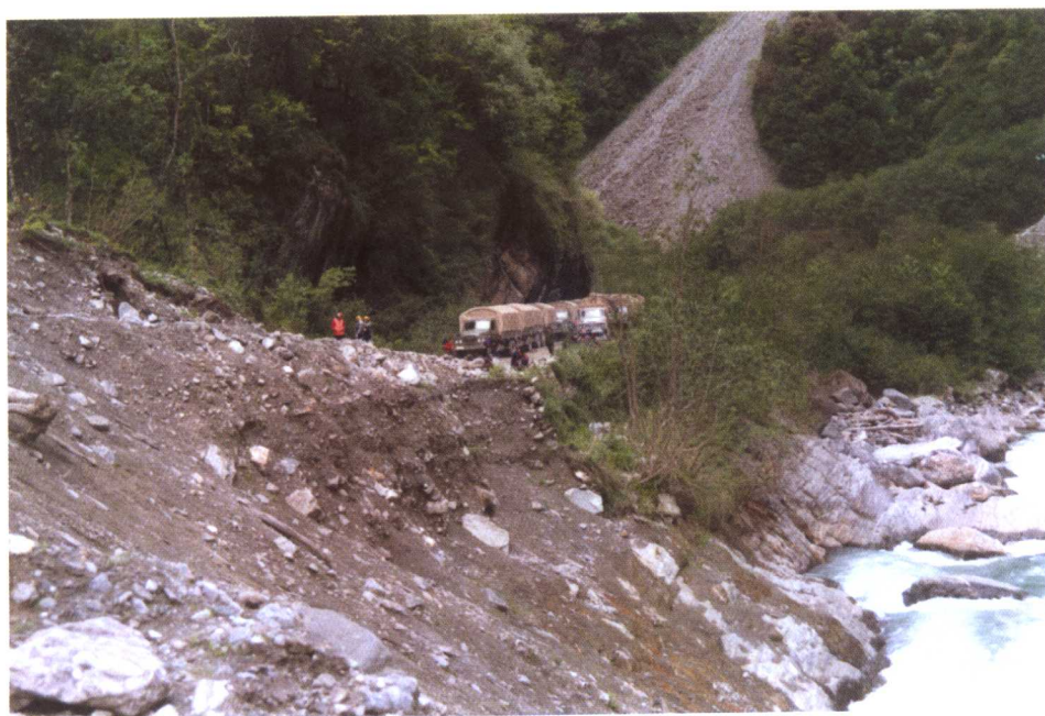
照片 2.10 崩滑泥石流造成公路严重阻塞
