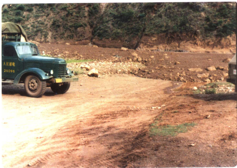
照片 2.9 崩塌泥石流阻断公路
