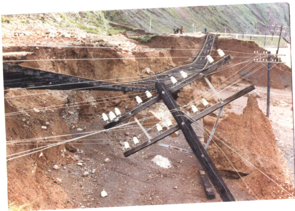
照片 2.7 泥石流破坏通讯线路
