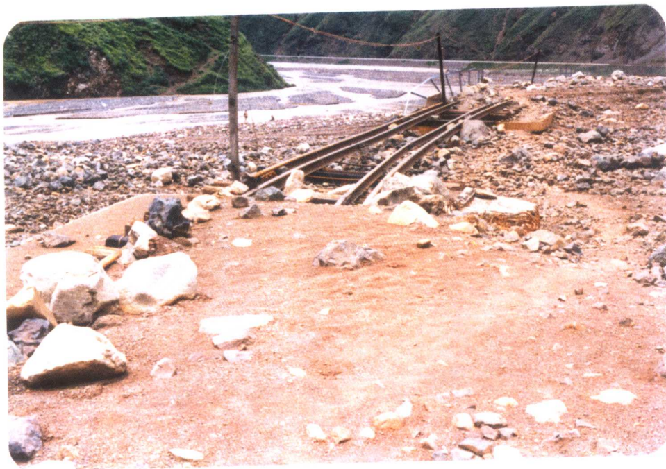
照片 2.3 泥石流淤埋铁路
