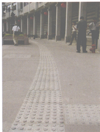
利用地方材料红米石铺砌的人行道及无障碍盲道
