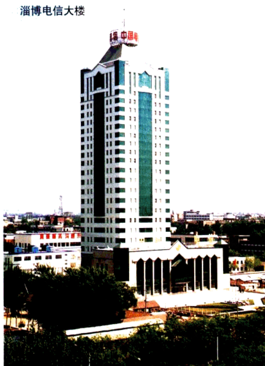
淄博电信大楼
