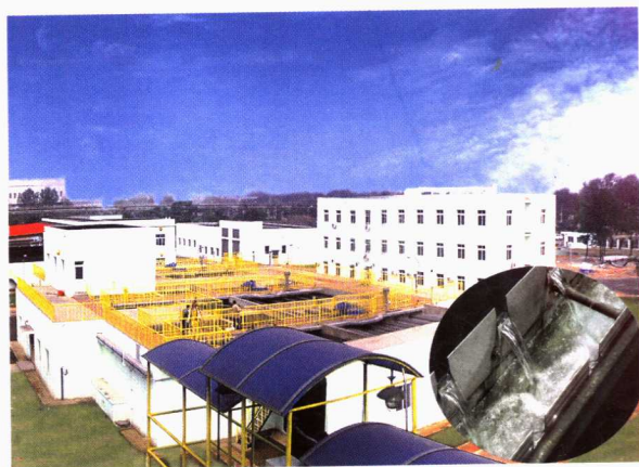
首钢厂区总污水处理厂
