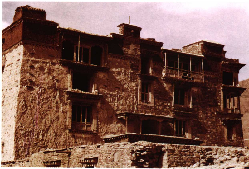
藏族碉房（清华大学建筑学院资料室供图）
