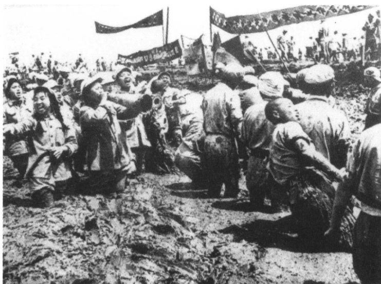
新中国第一个大型水利工程荆江分洪工程正在施工之中。
