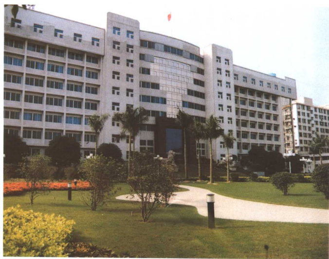
白云区人民政府大楼
