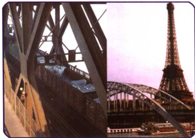
图2.9 金属桥梁、铁塔
