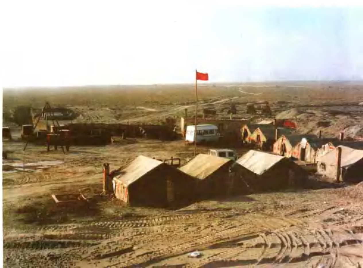
南疆铁路施工现场
