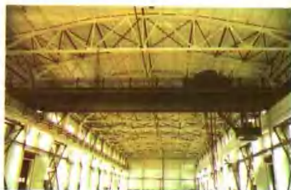
乌鲁木齐市东风锅炉厂厂房
