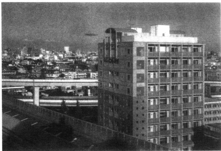
住宅被高架桥紧抱，危害甚大
