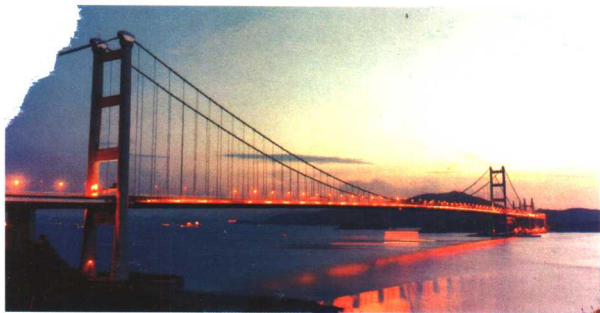
香港青马大桥
