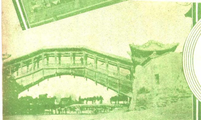
（車行橋下人行橋上）慈雄之橋 ↓（轉旋力流用利）車水河黃
