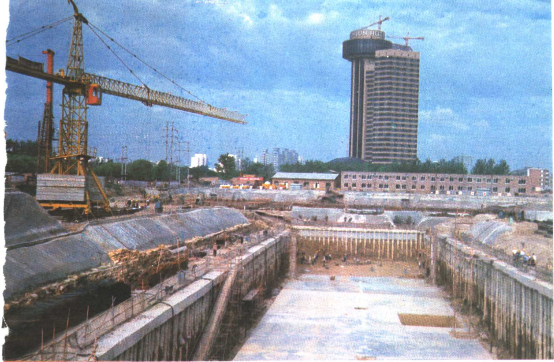
▲ 西德汉莎航空公司投资的北京康华地下工程公司承建的北京燕莎中主楼正在建设中
