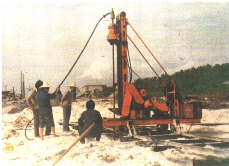
▼ 北京康华公司承建的海军某重要工程正准备开工
