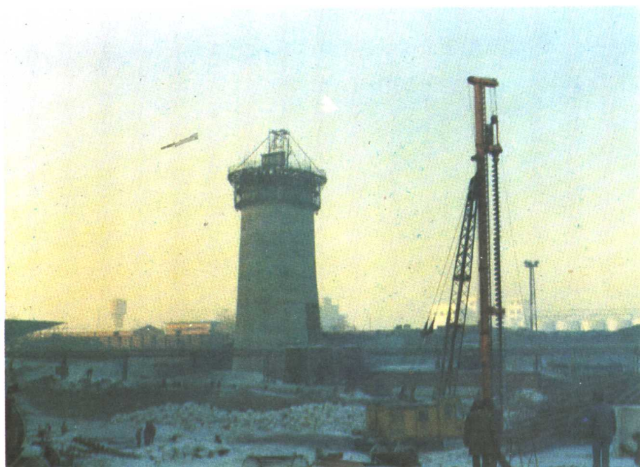
▼ 北京康华公司承建的哈尔滨热电厂正在施工中
