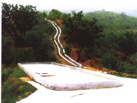
怀柔区宝山寺五小网络化工程坡面集雨水窖
