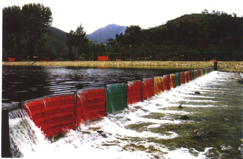
房山区佛子庄连拱闸拦蓄工程
