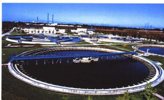
大兴区黄村污水处理厂
