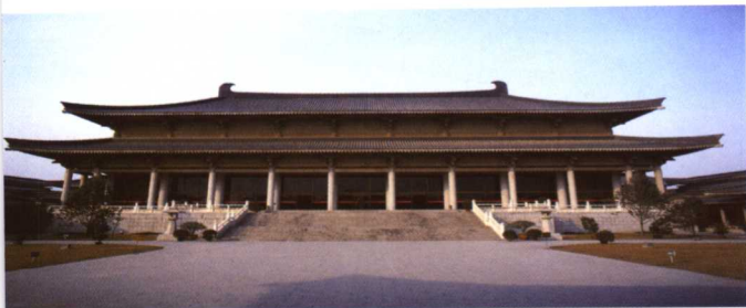
图 0-32 大屋顶建筑(中国)
