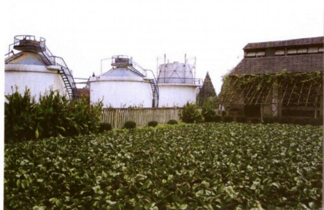
上海星火农场畜禽场沼 气工程，治理污染，又 为农场1 500 多户居民 供应优质、安全、卫生 的管道沼气
