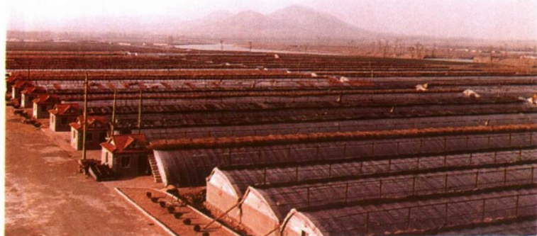
大连普兰店兴建的“四位一体”大棚 120 栋，占地 27 公顷
