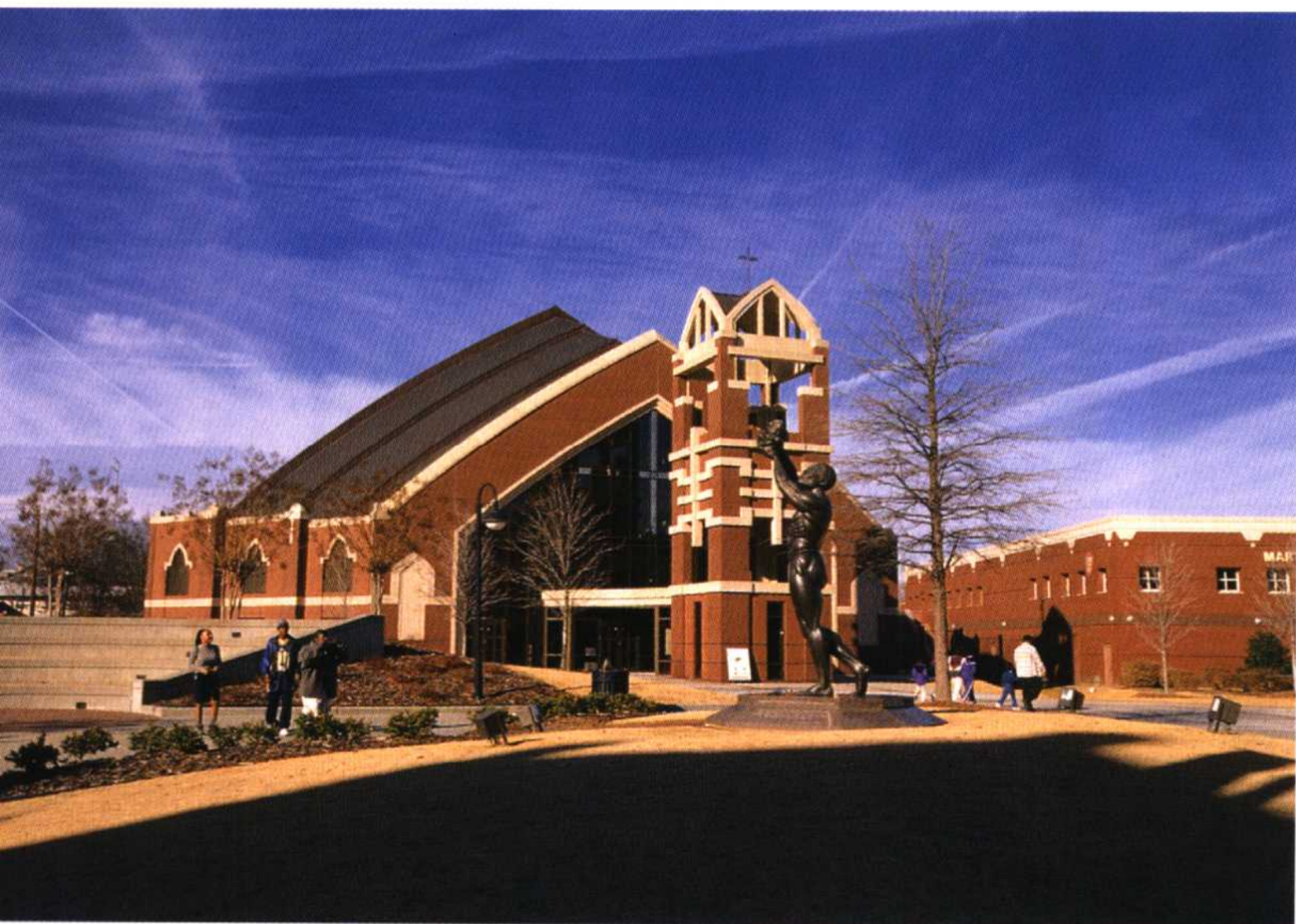
马丁路德·金历史纪念公园主 体建筑——展览馆
