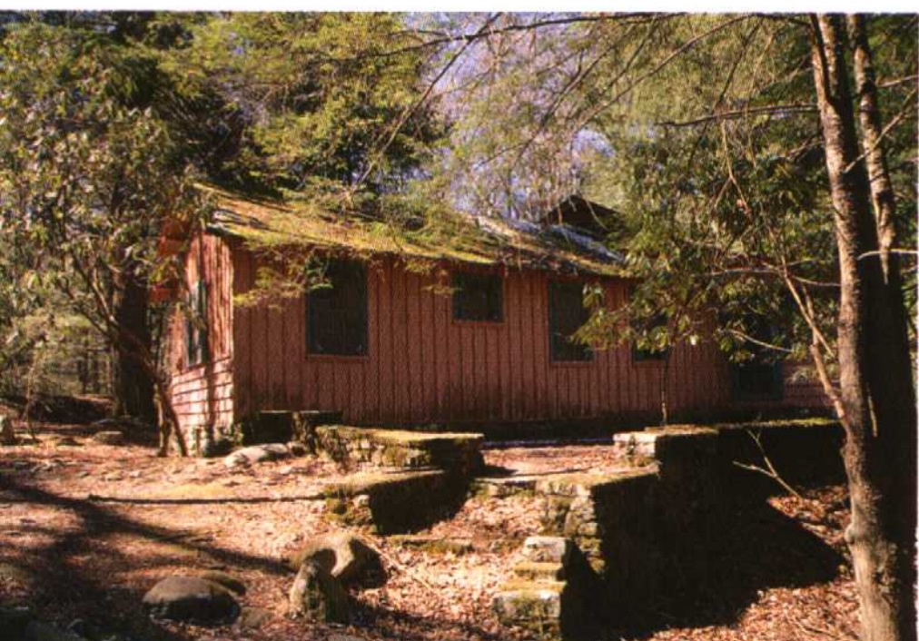
大雾山国家公园临时设施
