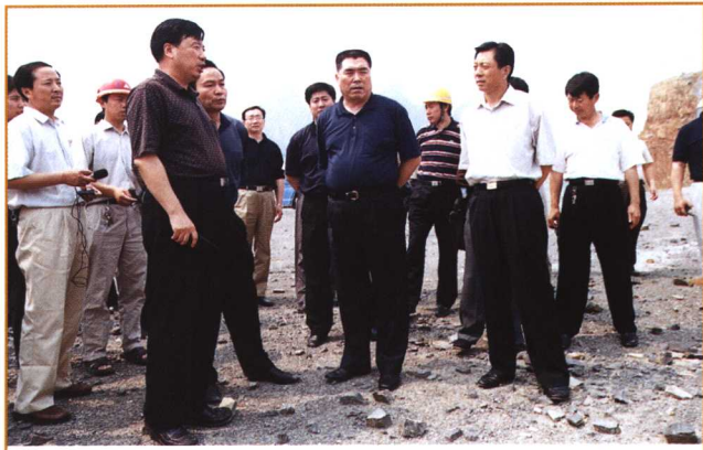
河南省省长李成玉(前中)到省重点工程鹤壁盘石头水库施工现场检查指导工作 (杨永轩 摄)
