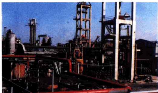
滕州化肥厂四万吨尿素工程
