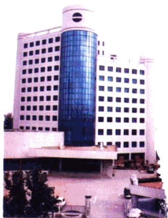
山东省军区办公楼(建设部优质样板工程)
