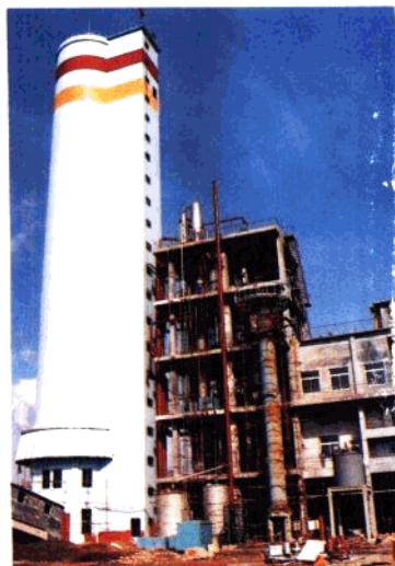
滕州化肥厂四万吨尿素工程
