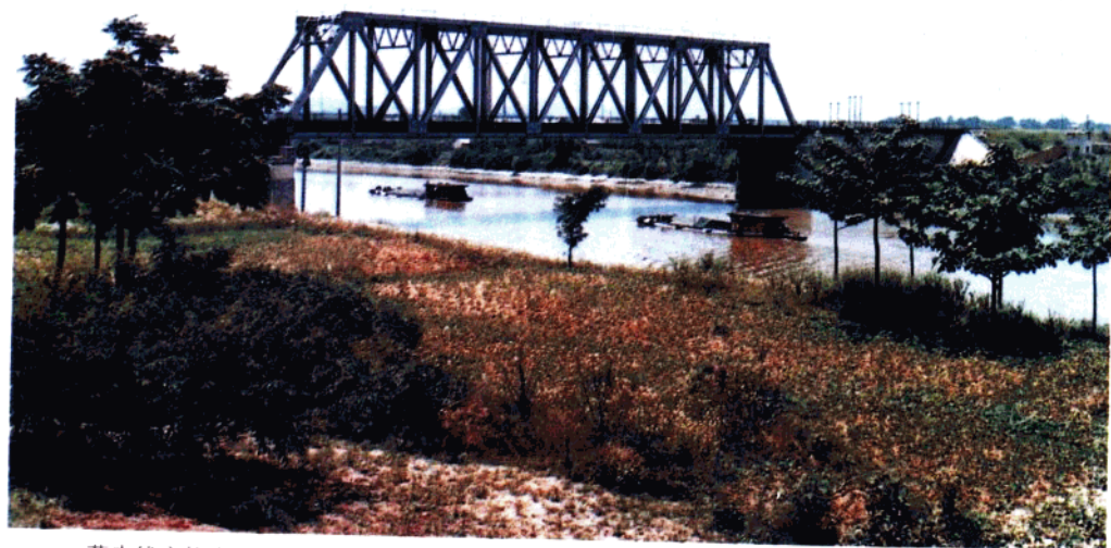
茅夹线京杭大运河跨度 80m 双线下承式钢横梁桥
