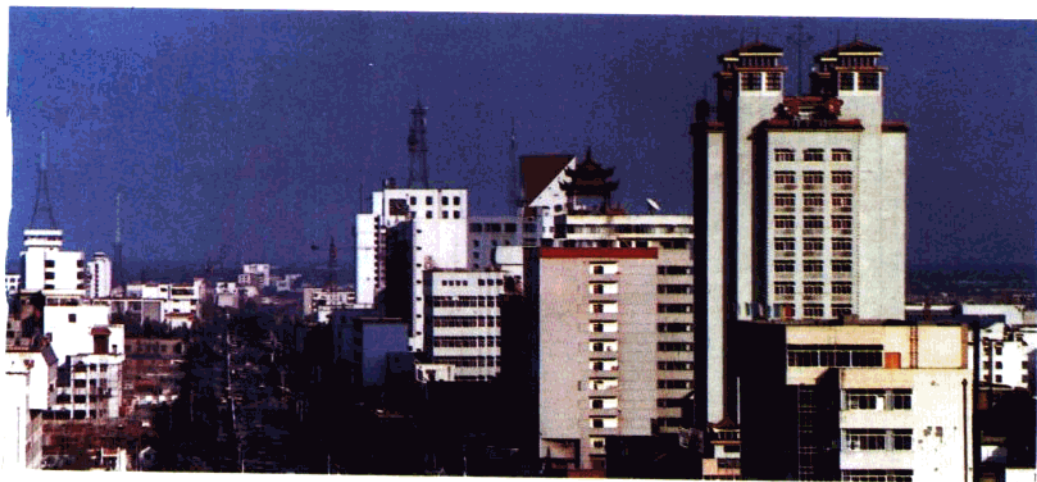
泰城东岳大街高层建筑群
