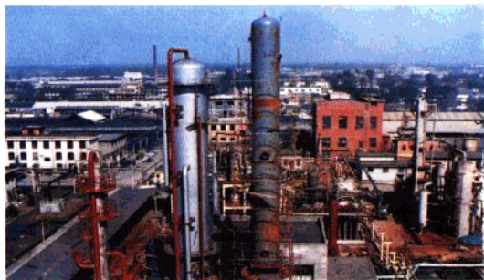
滕州化肥厂四万吨尿素工程
