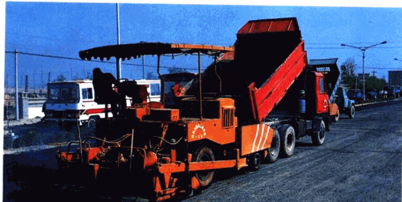
沥青路面施工
