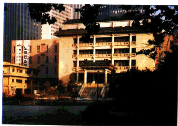
中国驻韩国大使馆修缮工程
