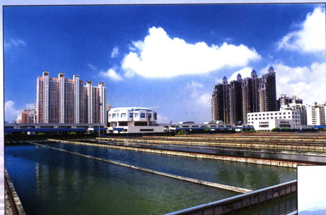
梅林水厂沉淀池
