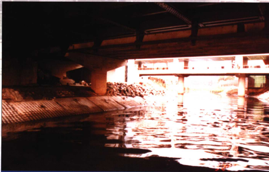
运用模袋混凝土技术进行罗湖铁路桥水下防护
