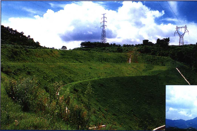
采用快速喷播植绿技术进行绿化
