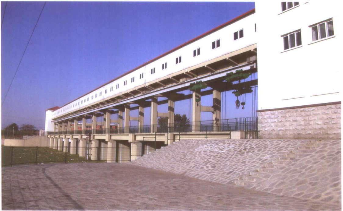
屈家店枢纽永定新河进洪闸
