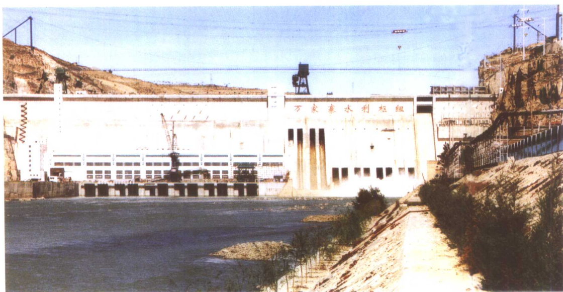
万家寨水利枢纽混凝土重力坝
