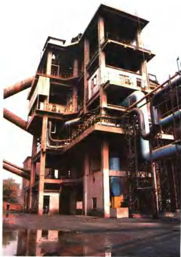
一铁竖炉改造工程竣工投产。
