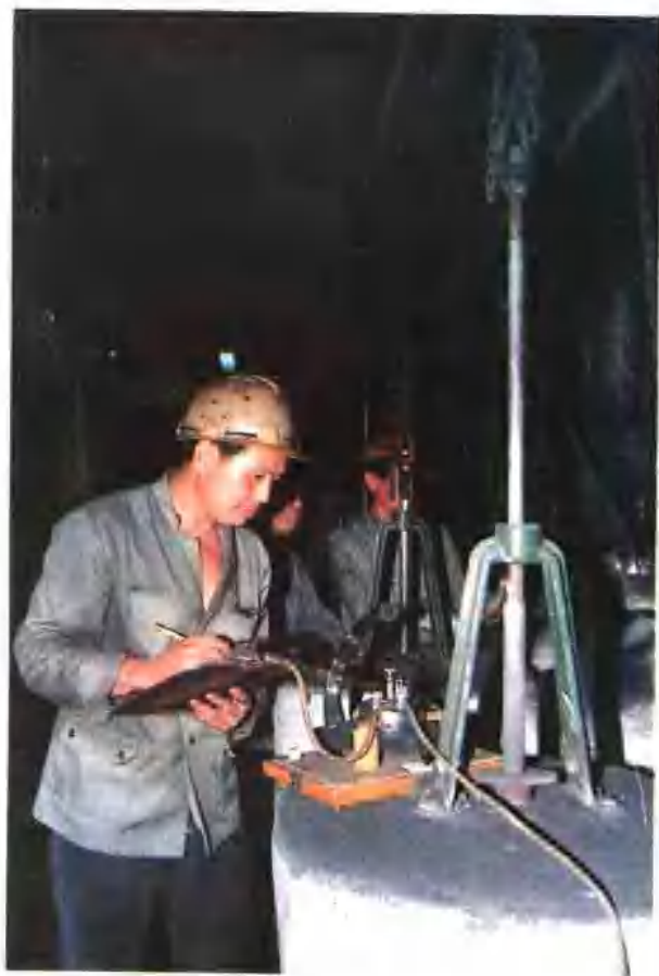
焦炉改烧高炉煤气系统投入生产。
