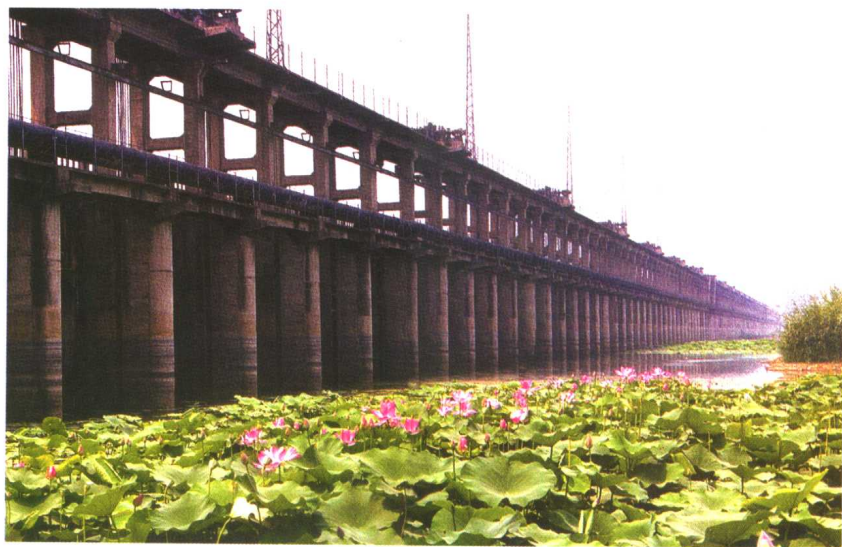
2.济宁微山湖二级坝节制闸
