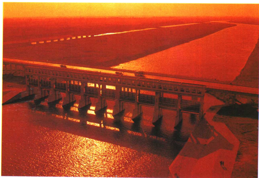
8. 枣庄运河万年船闸节制闸
