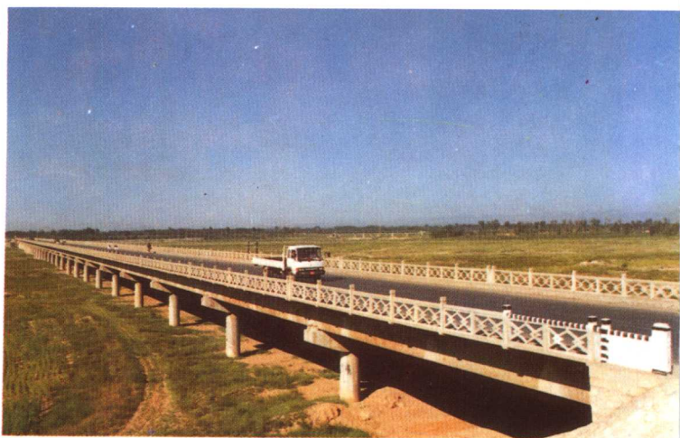
京深公路沙河市大沙河特大 T 梁桥
