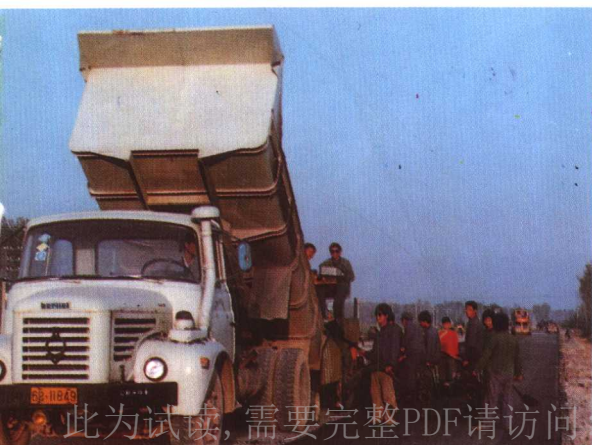
邢台地区交通局工程队铺筑 沥青(渣油)路面
