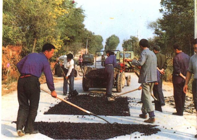
沙河市养路工挖补油路面
