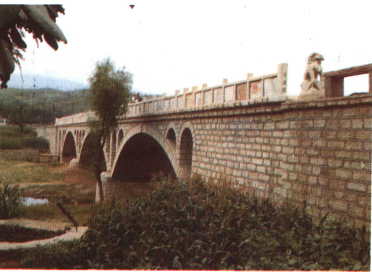
内白公路獐犸新式石拱桥
