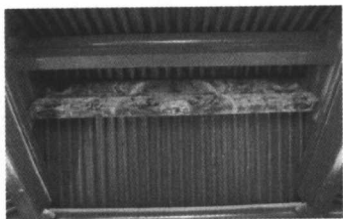
故宫畅音阁栊戏楼屋顶梁架
