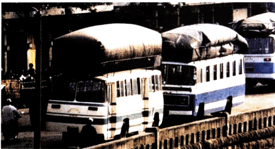
60年代前苏联对中国实施经济封锁时,中国许多汽车用煤气作燃料。
